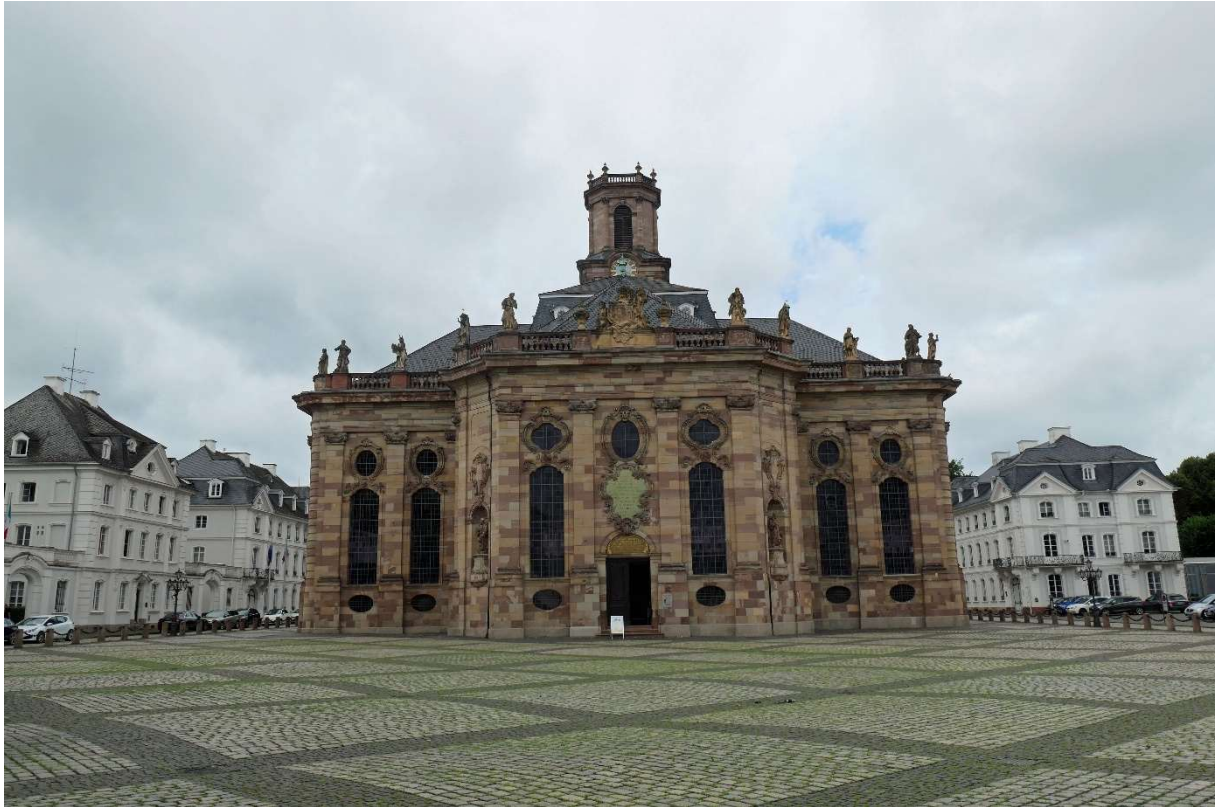
Bild 3: Ludwigskirche in Saarbrücken, erbaut vom Usinger Hofbaumeister Stengel
